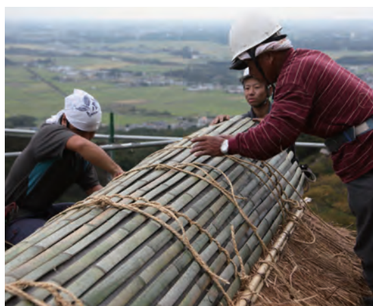
(上) 竹篋巻きで「グシ」（茅屋根の棟部分）をおさめるのが筑波流。
